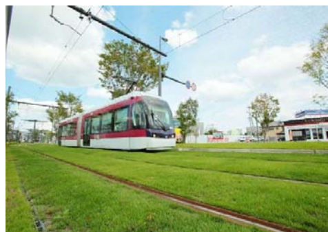
市電軌道敷緑化
