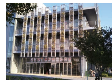
壁面緑化(ウエルバル熊本)
