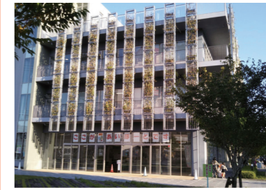
壁面緑化(ウエルバル熊本)
