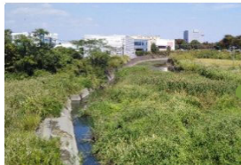
藻器堀川の多自然川づくり
